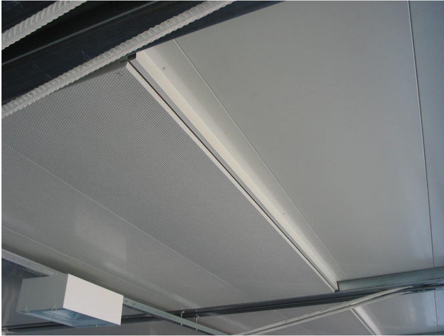
kész tetőfödémre rászertelt hangelnyelő burkolat
