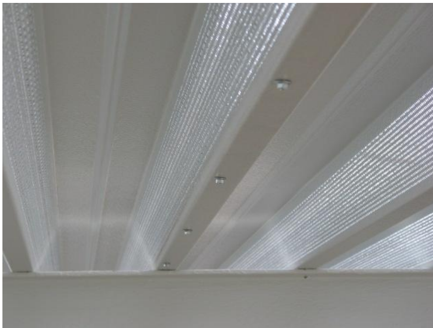
teherhordó trapézlemez perforált gerinccel – építés közbeni fénykép
